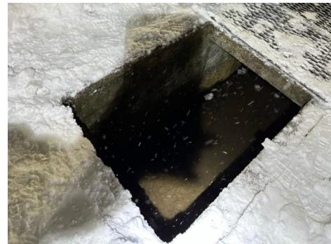
昨年開発した雪を落とせて作業員が落ちない流雪溝落下防止枠を俱知安駅用に設計
