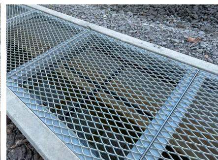
強度と安全性を検証し104機を製造し駅構内の流雪溝作業ポイントに雪が降る前に設置済み
